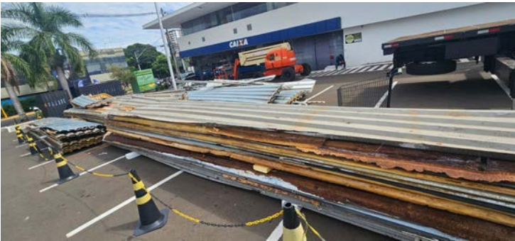
Troca de telhado da CEF Altos, em Bauru, tem gerado transtornos aos trabalhadores e clientes
